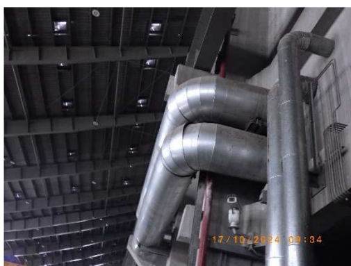
รูปที่ 2-32 ฉนวนกันความร้อนบริเวณท่อไอน้ำ
