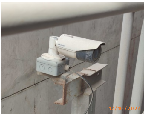
รูปที่ 2-48 การติดตั้งกล้องวงจรปิด สำหรับตรวจสอบระดับน้ำ ของหม้อไอน้ำ
