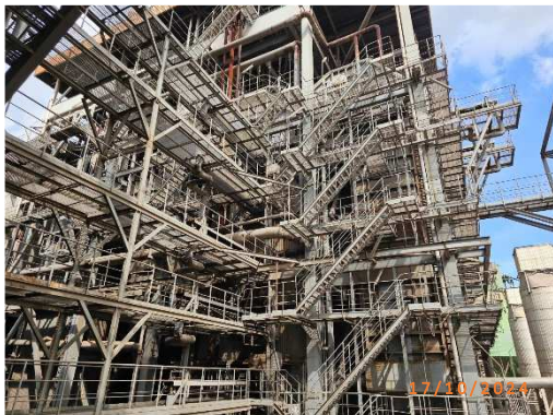
รูปที่ 2-42 อาคาร AQC Boiler ที่มีทางเดินและบันได พร้อมราวกันตก
