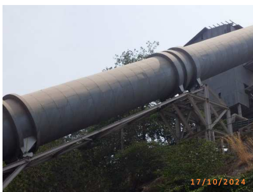
รูปที่ 2-52 ท่อลมร้อนที่ติดตั้ง Bypass Damper ของ AQC boiler
