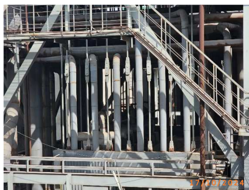
รูปที่ 2-47 Rapid Drain Piping System ของหม้อไอน้ำ
