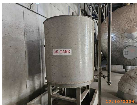
รูปที่ 2-58 การติดตั้ง Emergency Gravity Oil Tank ภายในโรงไฟฟ้า
