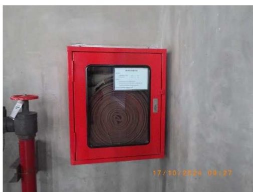
รูปที่ 2-38 ตู้เก็บสายดับเพลิง
